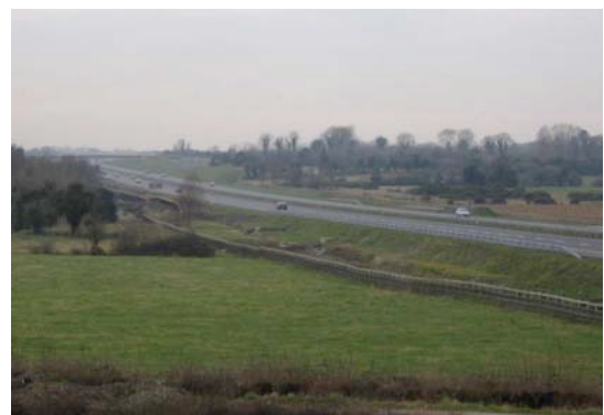
New M4 road corridor
